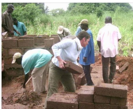
(Photo construction des latrines)
